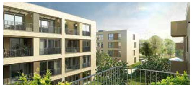
Ab Herbst 2014 errichtet Gundlach in attraktiver Lage am Lister Yachthafen 60 Eigentumswohnungen. Das Quartier liegt nur wenige Schritte entfernt vom Mittellandkanal . Um eine hohe städtebauliche Qualität zu erreichen, wurden drei Architekturbüros mit der Entwicklung und Umsetzung des Hochbaus beauftragt.
